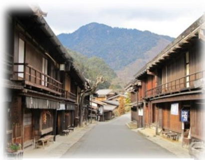
重要伝統的建造物群保存 地区(妻籠宿)
